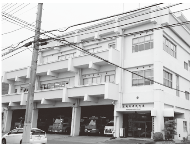
足利市消防本部現庁舎
